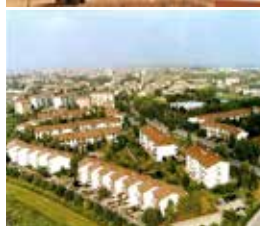
Quartiere Residenziale Fidenza (PR)
