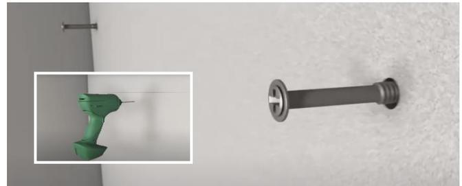
**5** Fissare la seconda lastra di cartongesso con la colla e/o con le apposite viti
