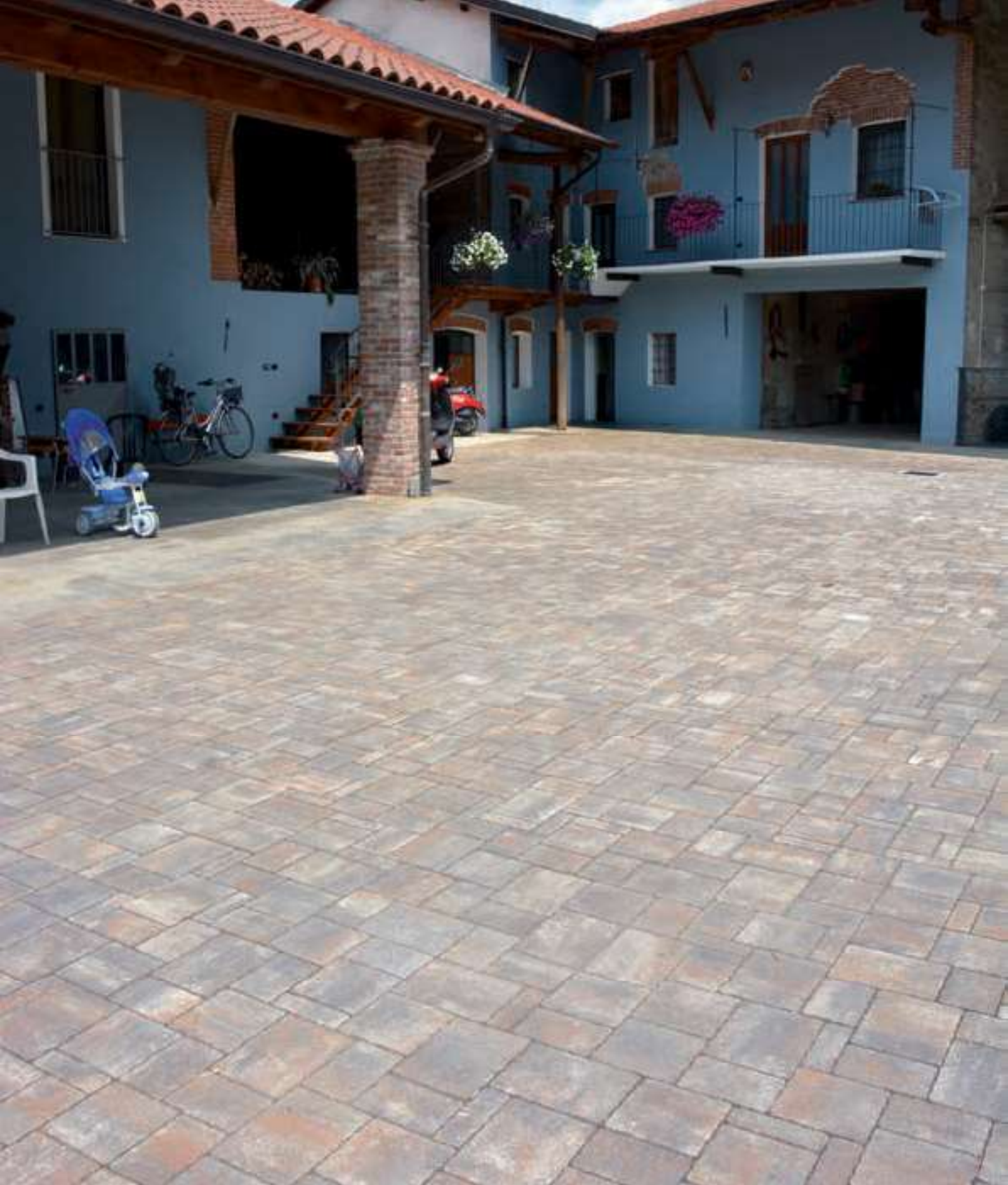
VIA MAESTRA couleur MIX ORANGE - scellement du joint avec sable polymère
