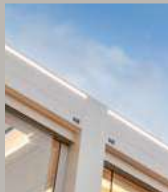
I led integrati nella struttura permettono un'illuminazione a luce indiretta: esterno, interno
