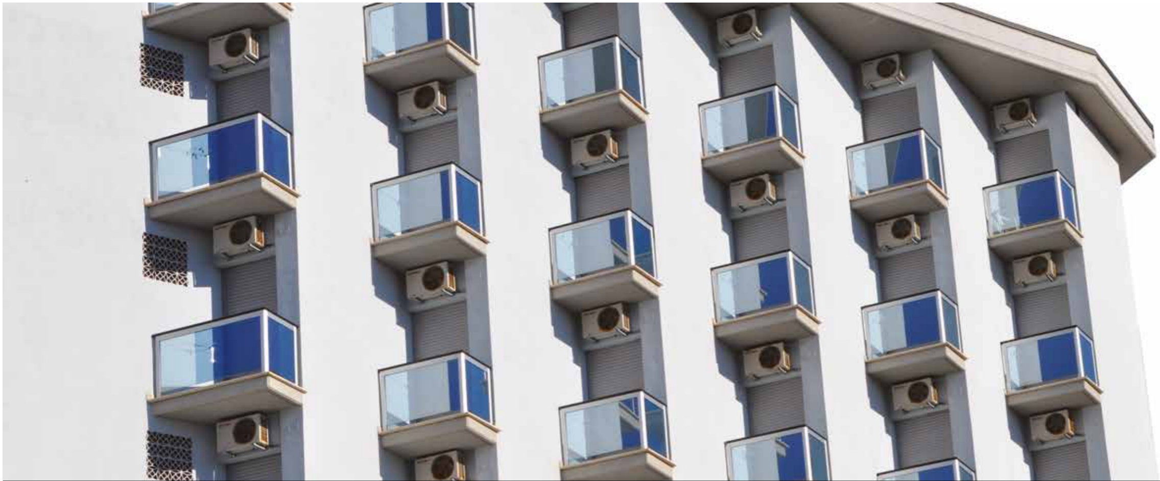
COSTRUZIONE DEGLI ANNI 60. BUILDING OF THE '60S
