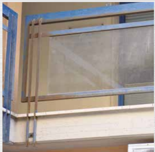
COSTRUZIONE DEGLI ANNI 80. BUILDING OF THE '80S
