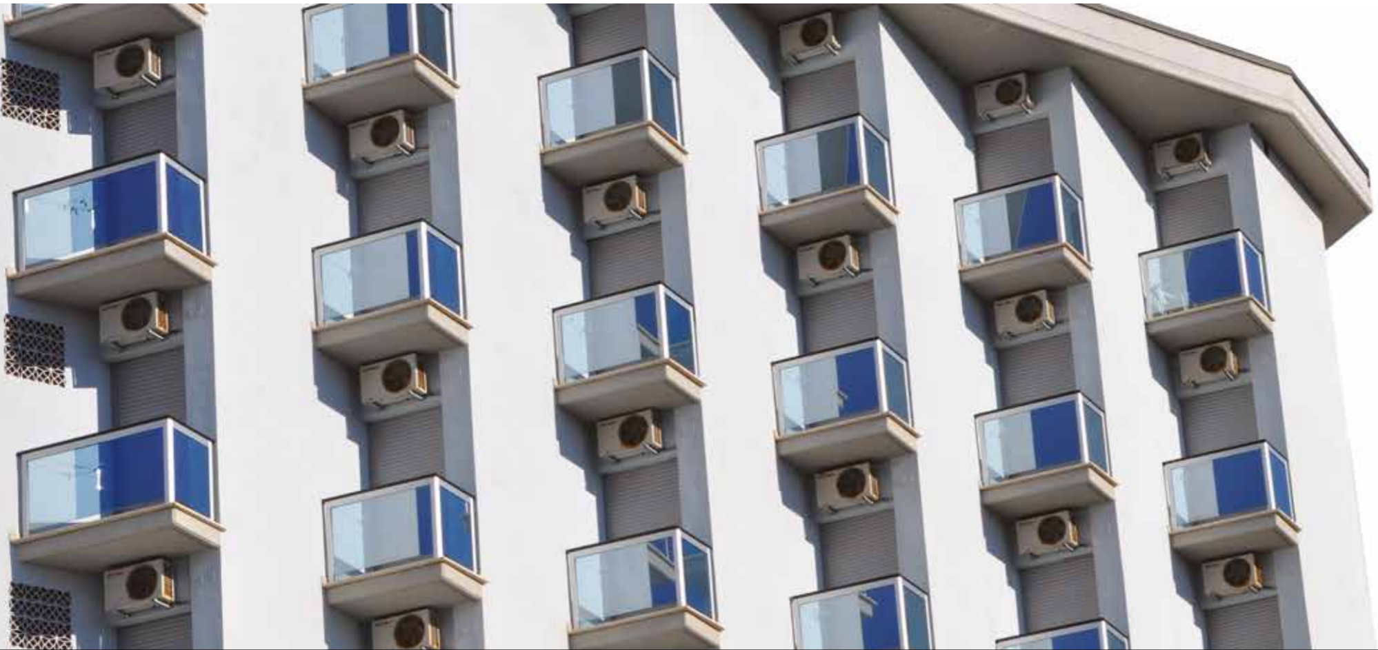
COSTRUZIONE DEGLI ANNI 60. BUILDING OF THE '60S
